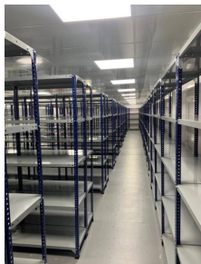
Estante de Aço — Instalação em Galpão Industrial
