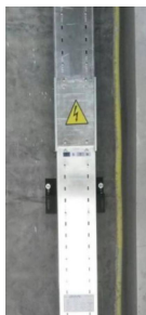
Trecho de Busway — Vista Detalhada
